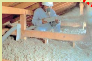
確実な断熱・ 気密施工
