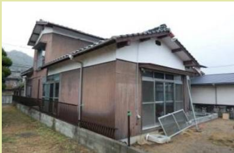
1972年竣工(築35年)、周南市
